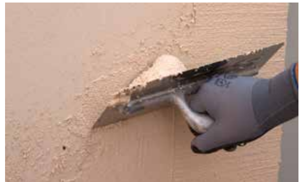
4. Aplicar PX-28 Isolxtrem SILOXANE TECHNOLOGY M no suporte.
