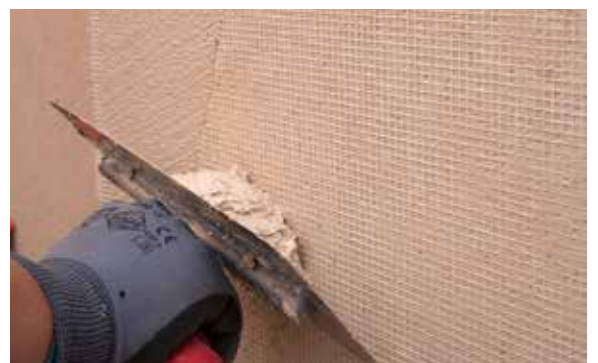
8. Cobrir a malha com PX-28 Isolxtrem SILOXANE TECHNOLOGY M.
