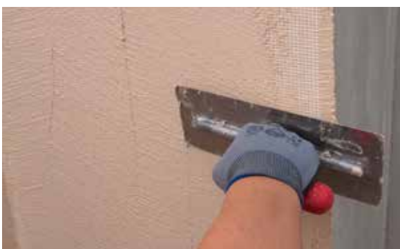
9. Alisar o PX-28 Isolxtrem SILOXANE TECHNOLOGY M depositado na malha.
