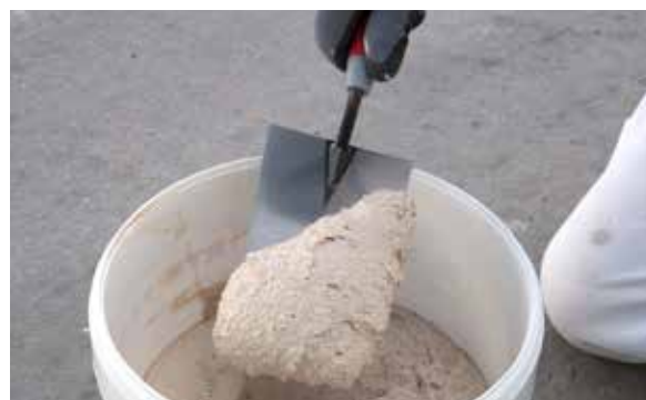
2. Extrair o PX-28 Isolxtrem SILOXANE TECHNOLOGY M com a ajuda de uma pá.
