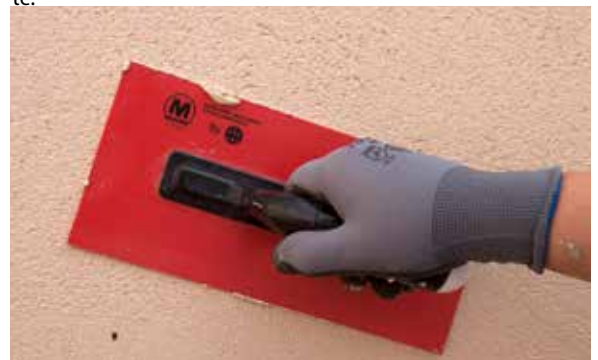
6. Espatular o PX-28 Isolxtrem SILOXANE TECHNOLOGY M.
