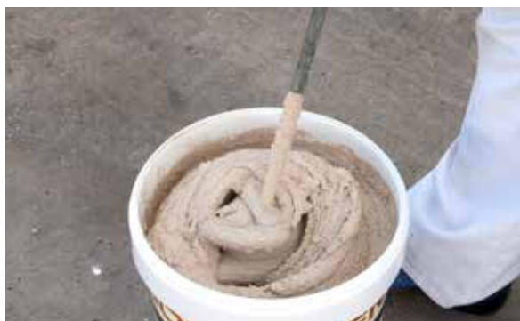
1. Remova o PX-28 Isolxtrem SILOXANE TECHNOLOGY M antes de usar.
