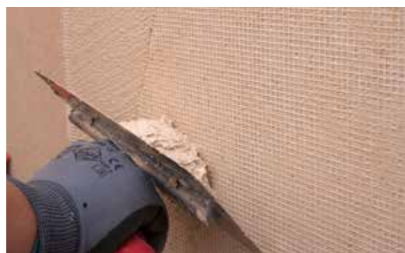
8. Cubra a malha com PX-28 Isolxtrem SILOXANE TECHNOLOGY L.
