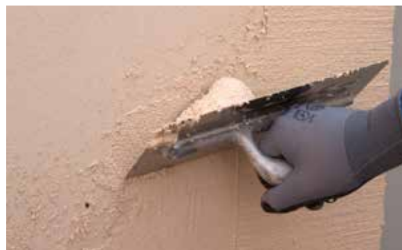
4. Aplicar PX-28 Isolxtrem SILOXANE TECHNOLOGY L no suporte.
