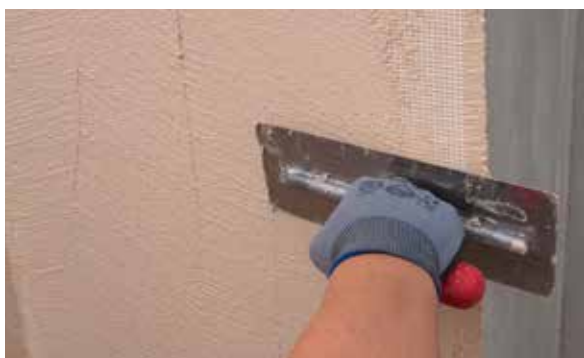
9. Alisar o PX-28 Isolxtrem SILOXANE TECHNOLOGY L depositado na malha.
