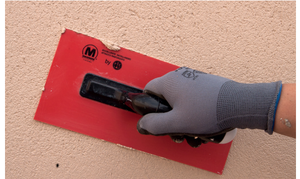
6. Trowel the PX-20 Isolxtrem RTX M.
