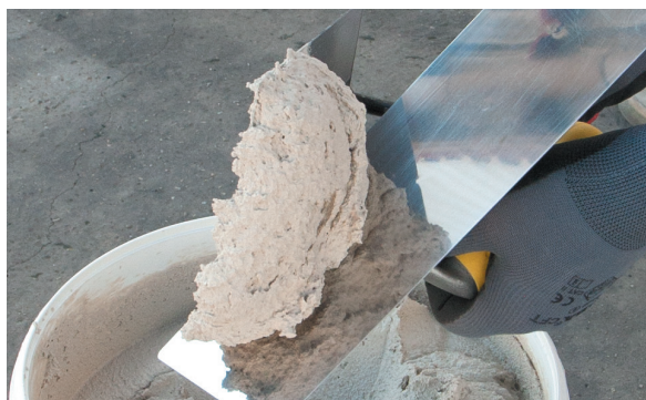
3. Colocar PX-20 Isolxtrem RTX L en la llana.
