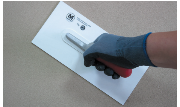
6. Fratar el PX-20 Isolxtrem RTX L.
