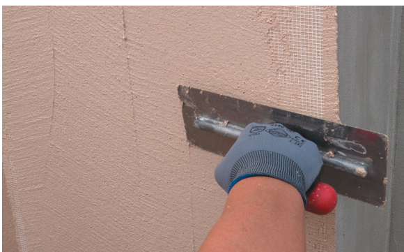
9. Alisar el PX-20 Isolxtrem RTX L depositado sobre la malla.
