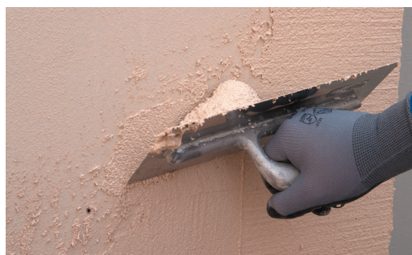
4. Aplicar PX-20 Isolxtrem RTX L sobre el soporte.
