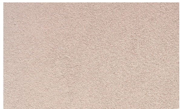
10. Acabado final del PX-20 Isolxtrem RTX L.
