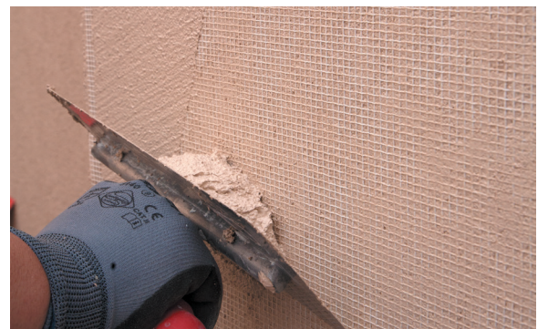
8. Cubrir la malla con PX-20 Isolxtrem RTX L.
