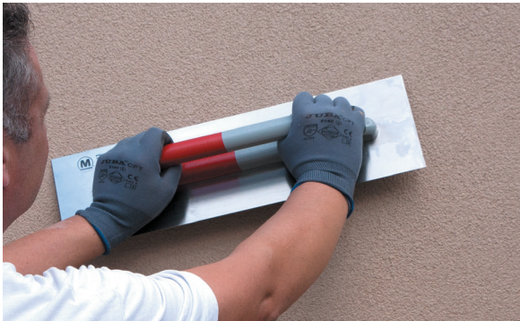
5. Alisar el PX-20 Isolxtrem RTX L.
