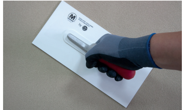
6. Trowel the PX-20 Isolxtrem RTX F.
