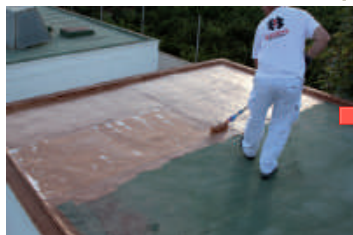
Anciens revêtements d'imperméabilisation
