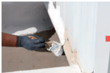
Anciens revêtements d'imperméabilisation
