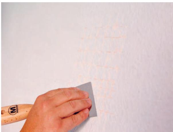
Si le support ne montre aucun décollement, craquellement ou faïençage, et s'il supporte le test du quadrillage, nous pouvons alors appliquer l'enduit en pâte RUALAIX +CONFORT 2 EN 1 sans craindre le moindre problème technique.
