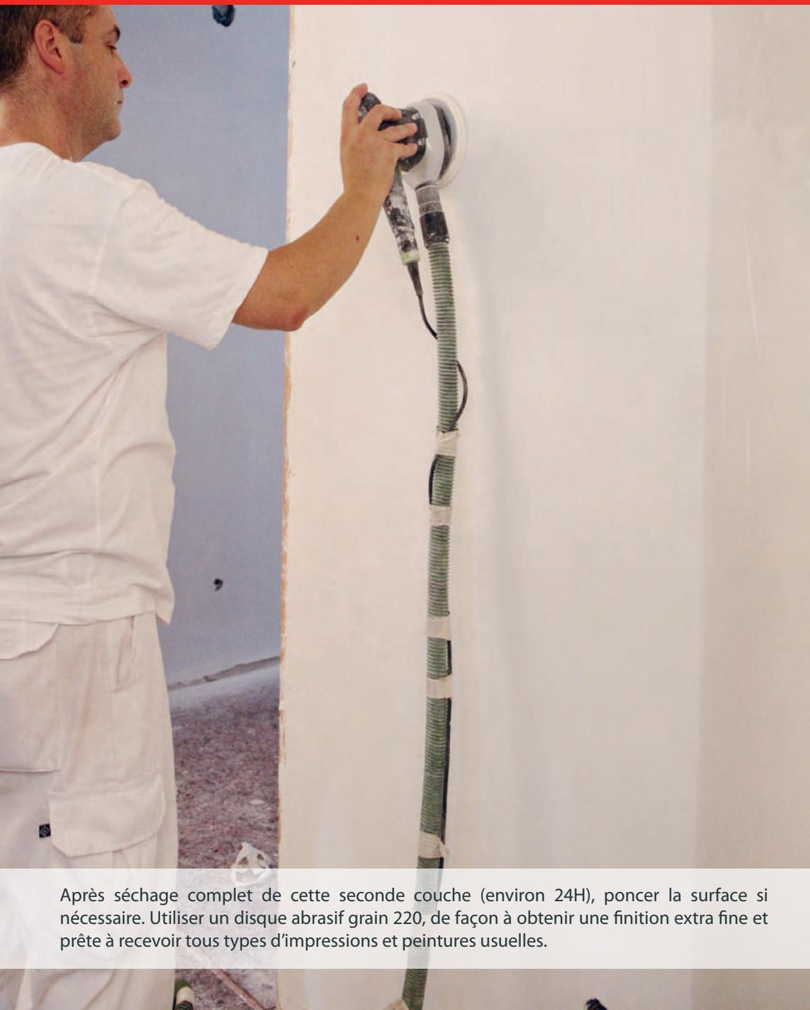
Après séchage complet de cette seconde couche (environ 24H), poncer la surface si nécessaire. Utiliser un disque abrasif grain 220, de façon à obtenir une finition extra fine et prête à recevoir tous types d'impressions et peintures usuelles.
