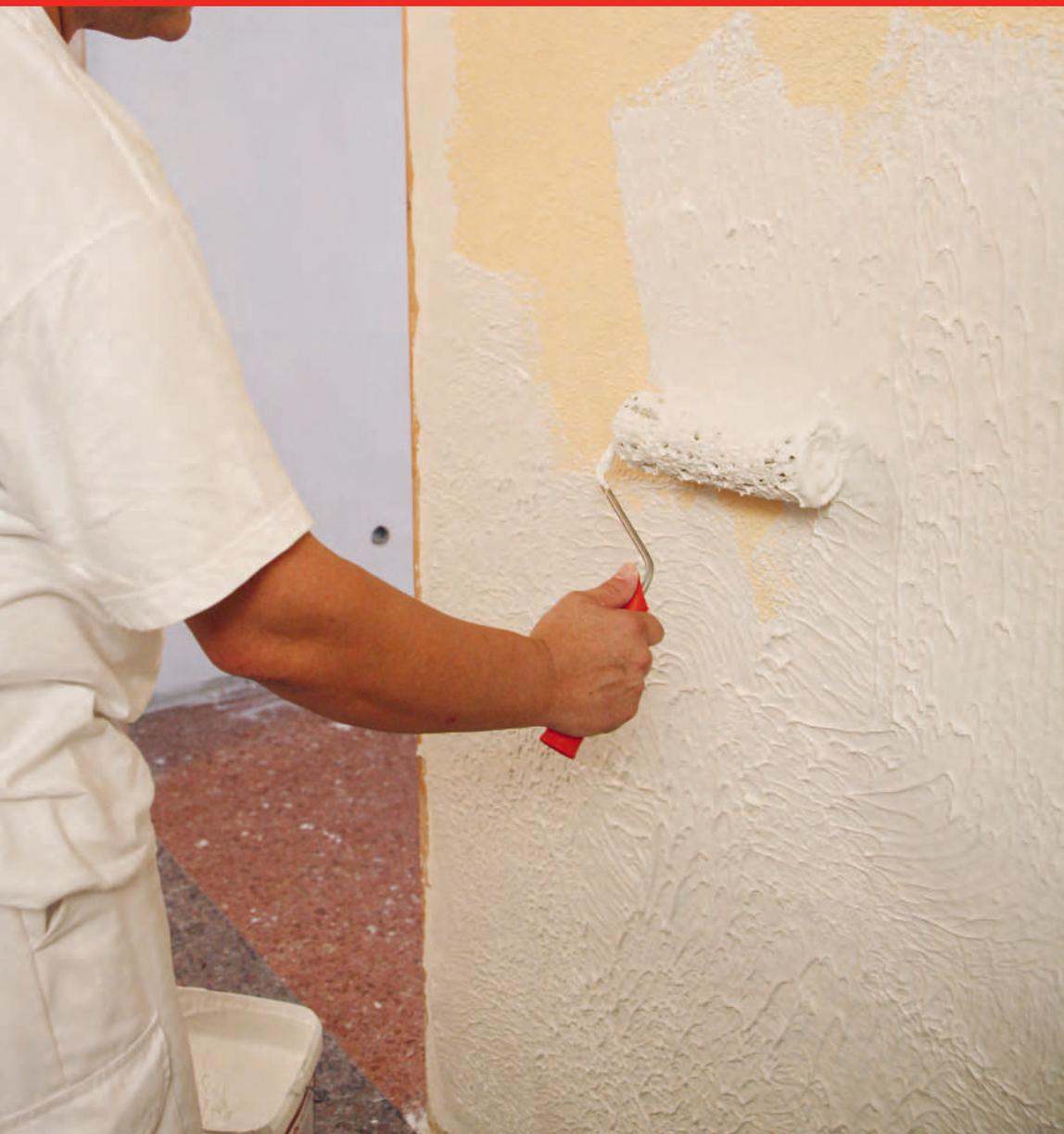
Nous conseillons de déposer l'enduit sur des panneaux/tronçons d'environ 2m<sup>2</sup>, de façon à éviter que le produit ne commence à sécher, ce qui poserait problème lors de l'opération de lissage ultérieurement.
