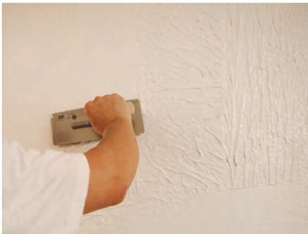
Après avoir déposé l'enduit au rouleau, lisser aussitôt la pâte avec une lame à enduire ou une lisseuse traditionnelle, de façon à aplanir et niveler la surface.
